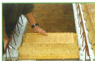
Sa légèreté se traduit par une mise en œuvre facile et rapide du plancher : une palette de 630 Kg (120 pièces) permet la réalisation d'un plancher de 87 m<sup>2</sup>. Les nervures transversales assurent une grande rigidité et permettent une découpe facile à la main, sans aucun outil. L'about EBM-A, commun aux entrevois de 13 et 16 cm, garantit une parfaite jonction avec les murs et élimine tout rebus grâce à son système de réglage breveté.
