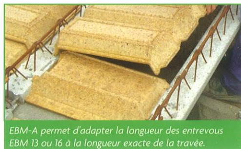
EBM-A permet d'adapter la longueur des entrevous EBM 13 ou 16 à la longueur exacte de la travée.
